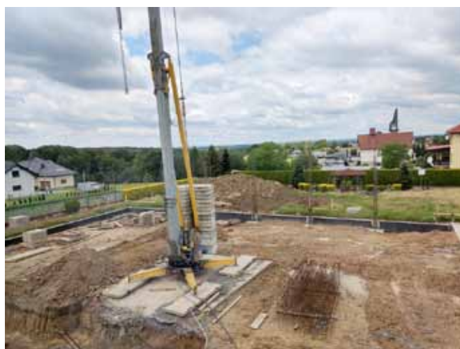
Sala sportowa w Janowicach – stan na koniec czerwca 2022 r.
