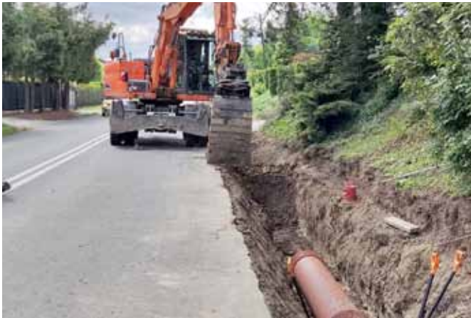
Budowa chodnika – ul. Witosa w Bestwinie
