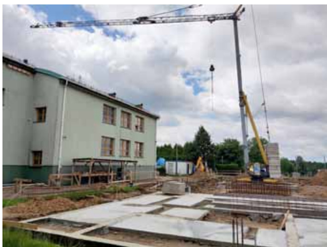
Budowa sali sportowej w Janowicach.
